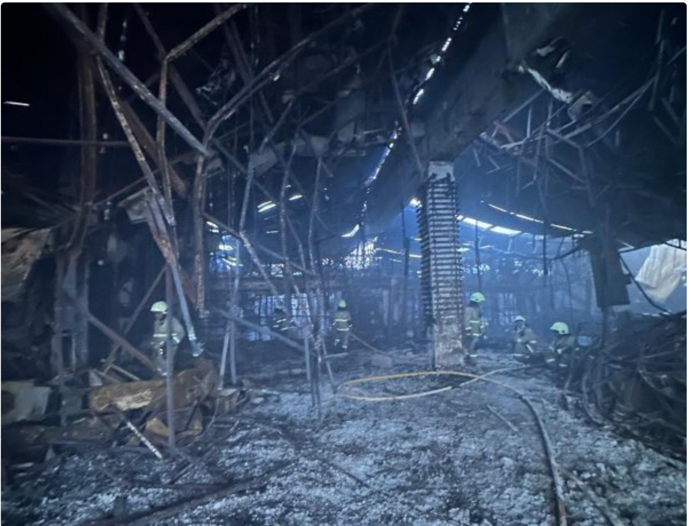
Glodok Plaza yang Hangus Terbakar
